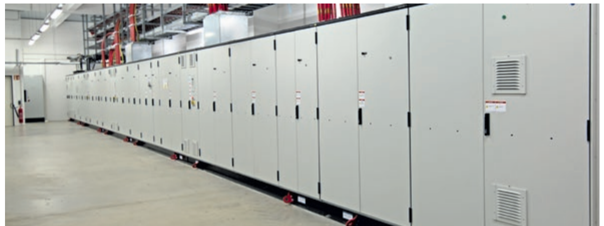
Umrichtersystem im DyNaLab zur Netznachbildung
